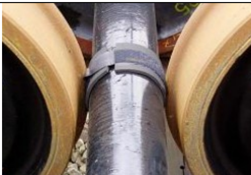
slika 4: skladiščenje na zamaknjenem tiru z zaščito proti dotikanju
